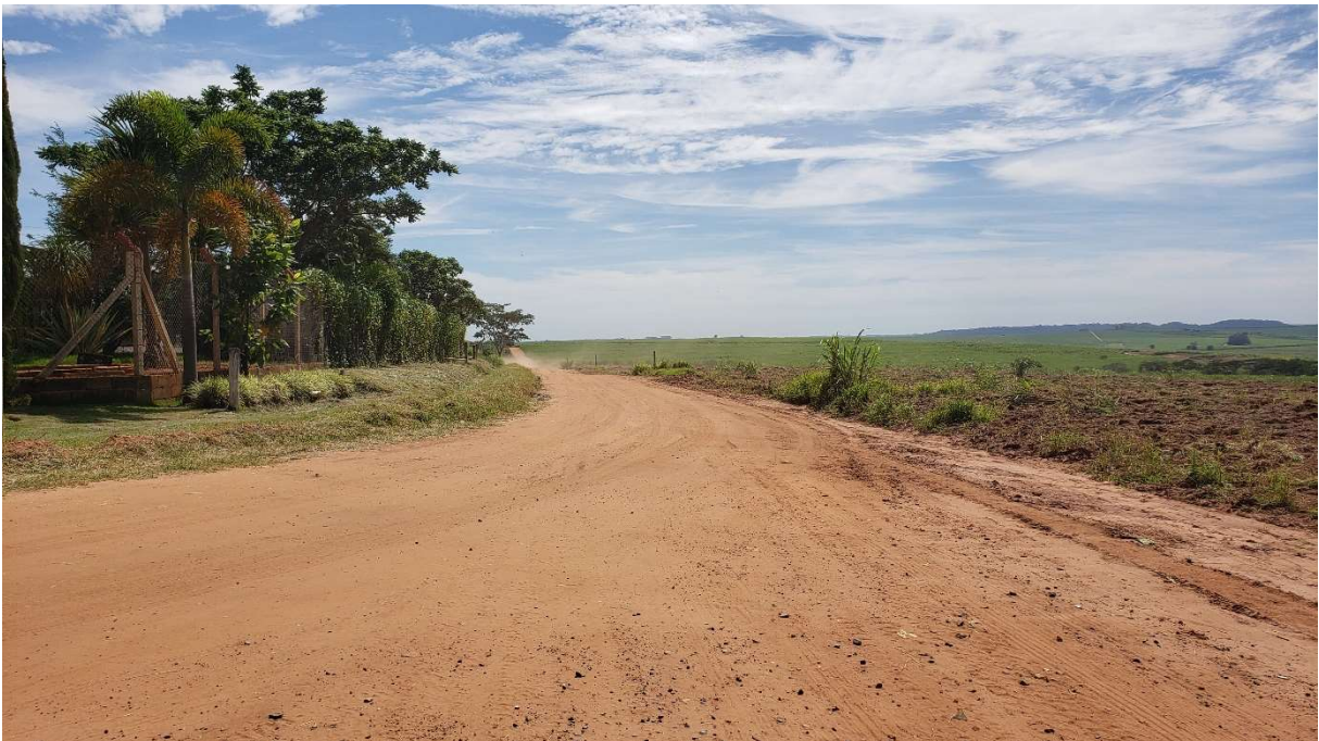
Figura 41 – Trecho inicial da estrada.
