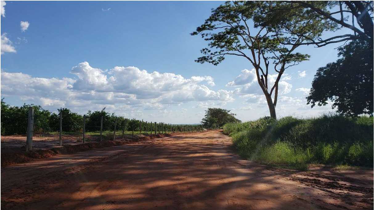
Figura 68 – Início da estrada em seus aspectos gerais.
