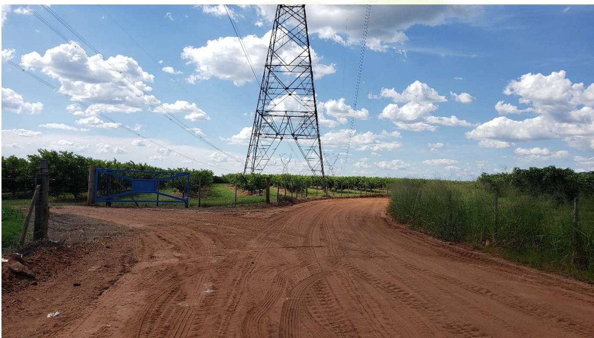
Figura 58 – Estrada sob linhas de transmissão.
