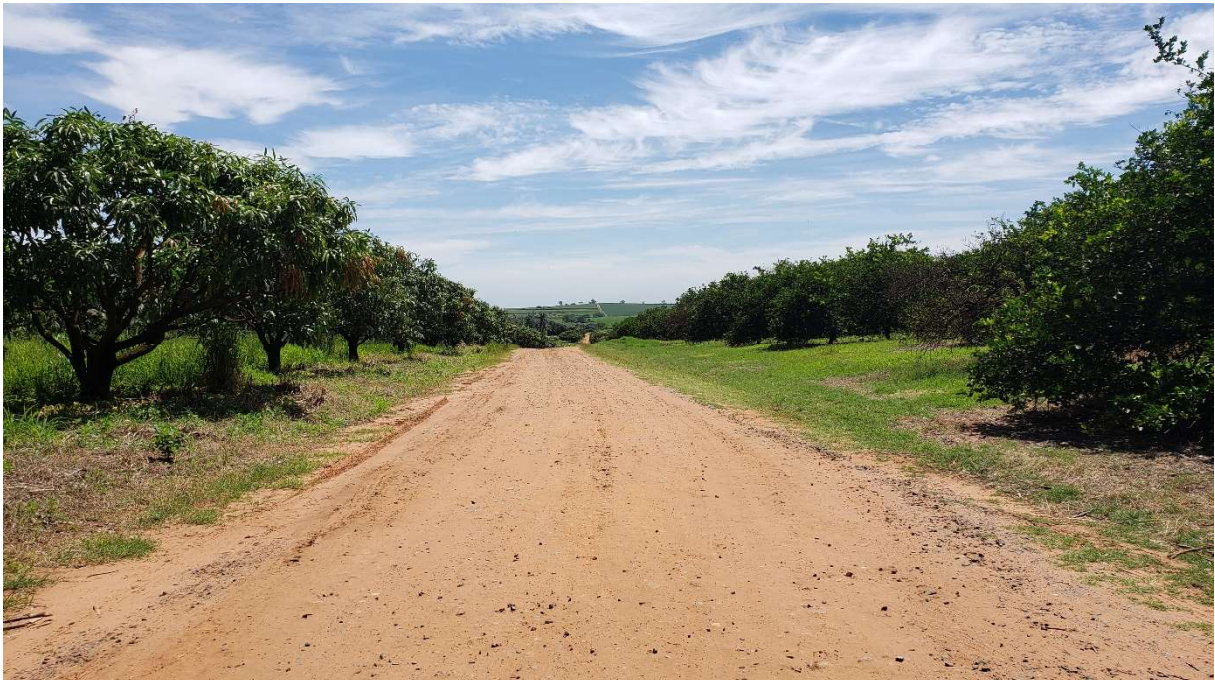
Figura 50 – Estrada com a plataforma não conformada.
