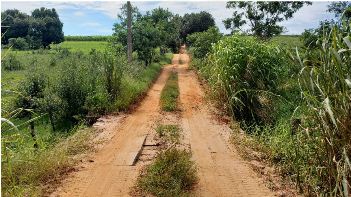
Figura 40 – Ponte de madeira
