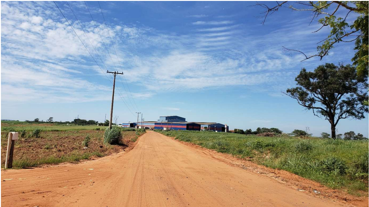
Figura 42 – Estrada sem revestimento.
