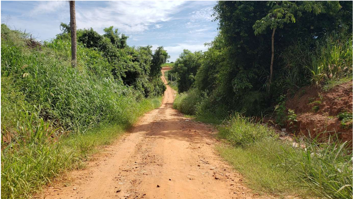
Figura 39 – Valetas na lateral da estrada.
