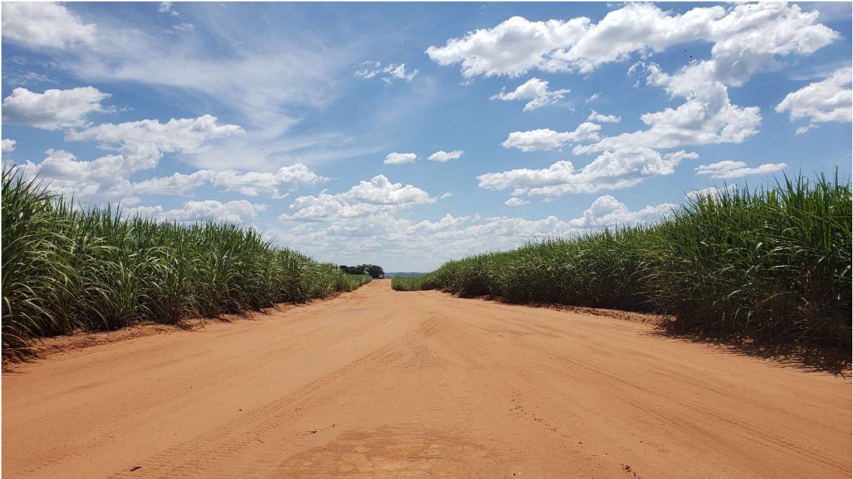
Figura 53 Longo trecho sem revestimento.
