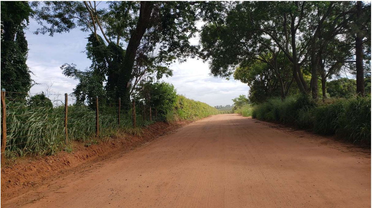
Figura 35 – Estrada sem saída d'água.
